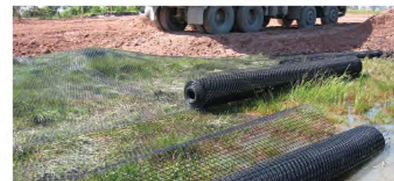
地基加固, 路面停车场, 英国
