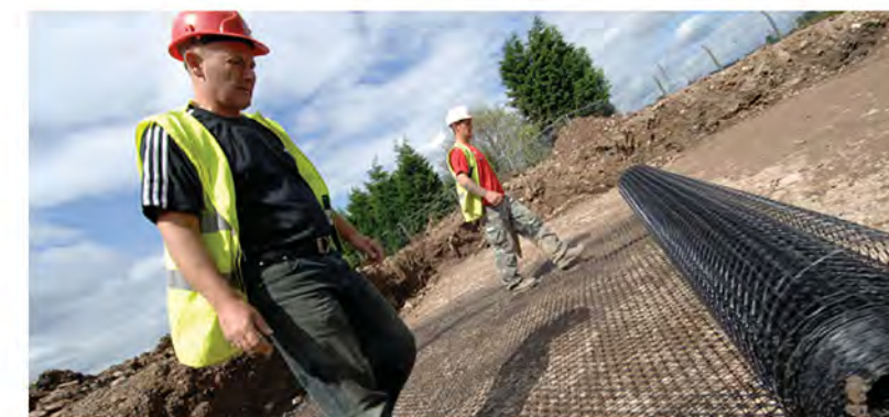
三向土工格栅®铺设, 英国Stoke
