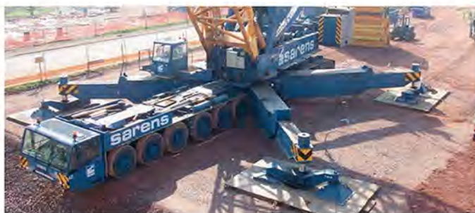
坦萨地基加固后的工作平台上的重载起重机
